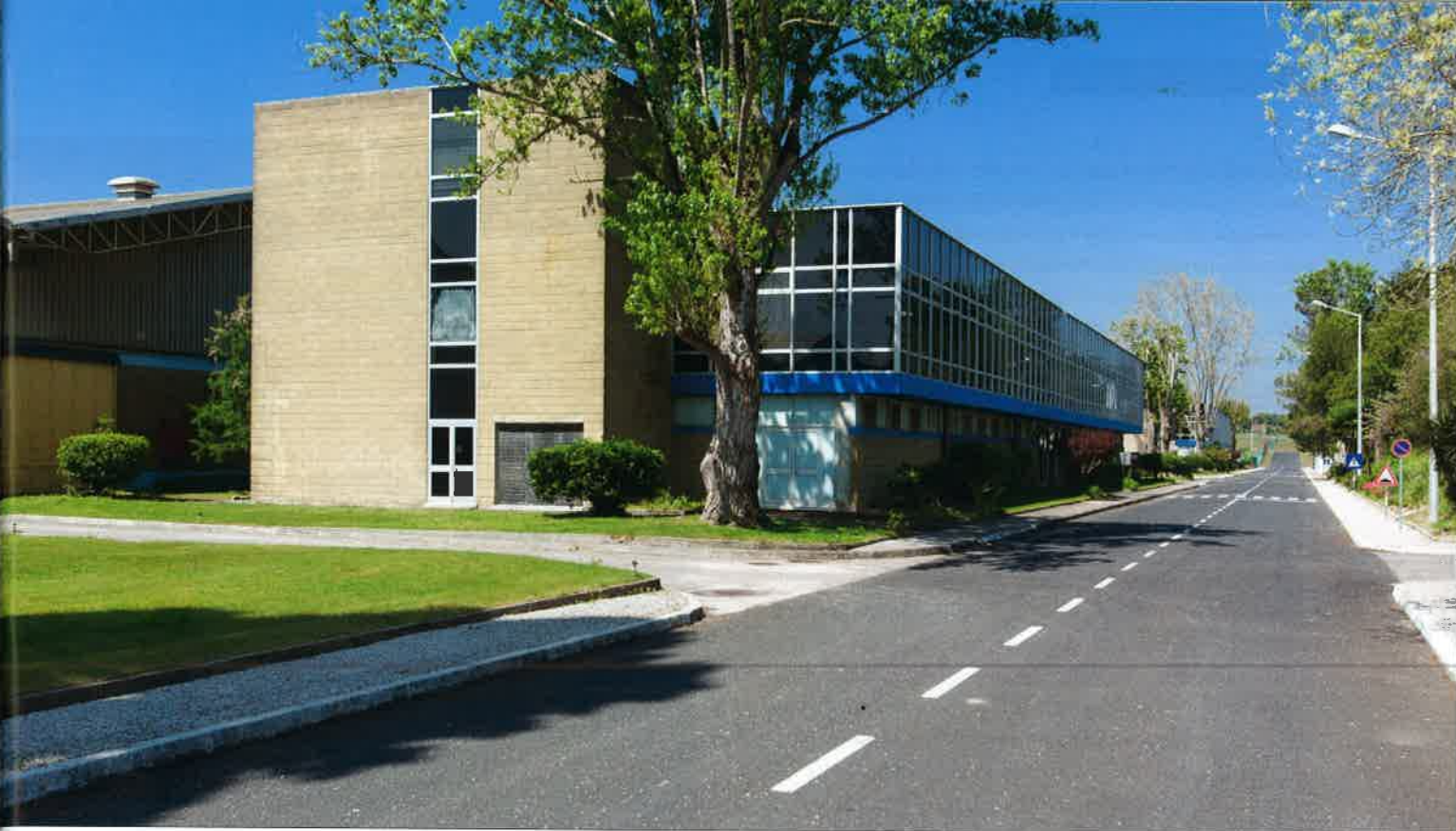
BlueBiz - Edifícios de Escritórios
